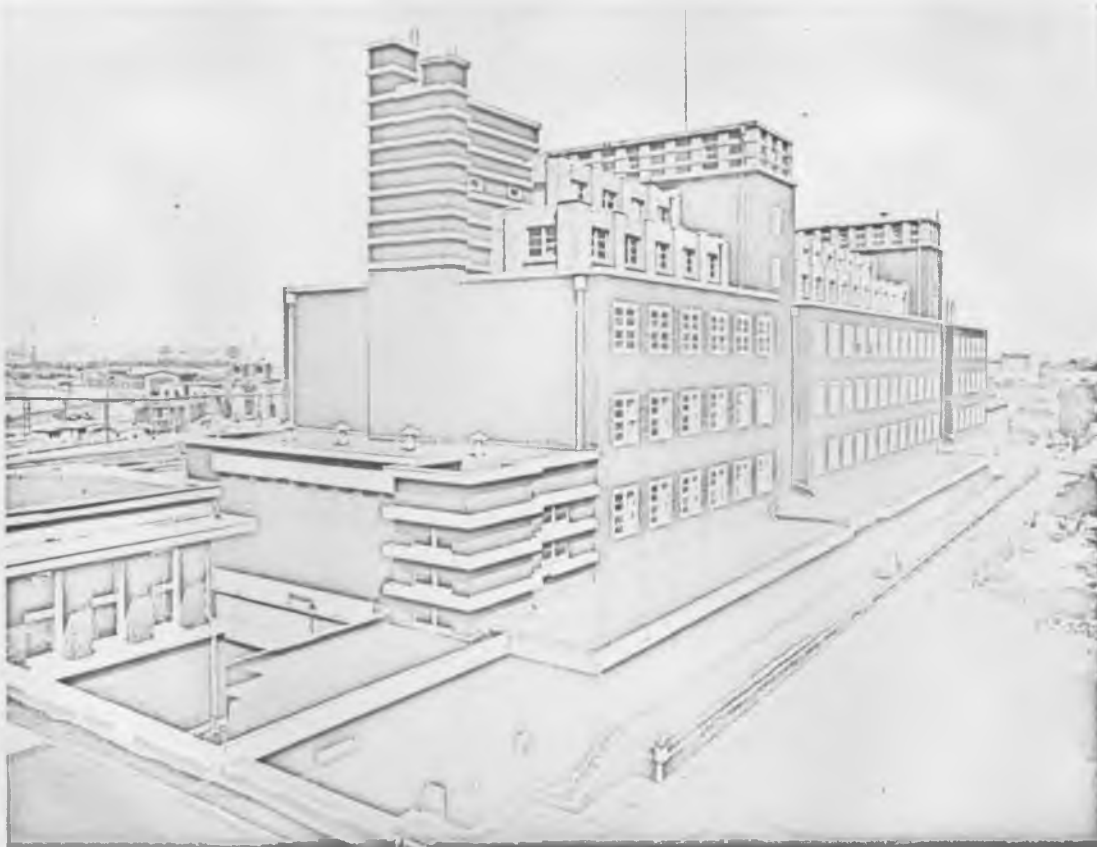
10. Gutehoffnungshütte Oberhausen, Hauptlagerhaus von Peter Behrens (1920–1925). Aufnahme 1969.
